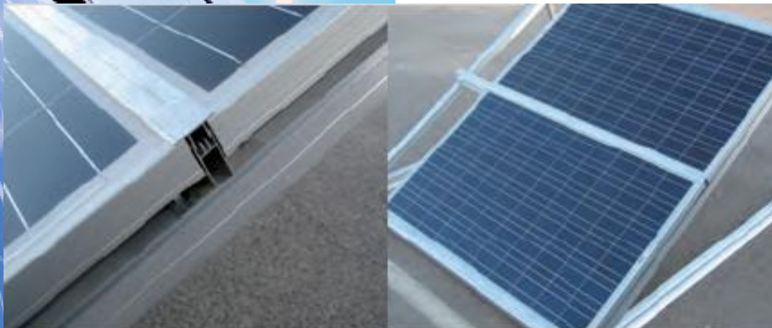
STAFFE ANCORAGGIO PER TIPOLOGIA DI COPERTURA
