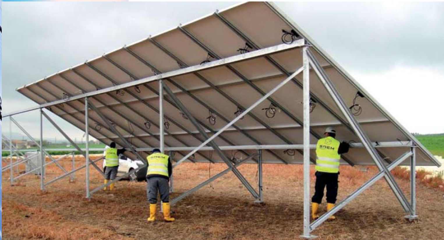
PALO FONDAZIONE E BASE STRUTTURA
